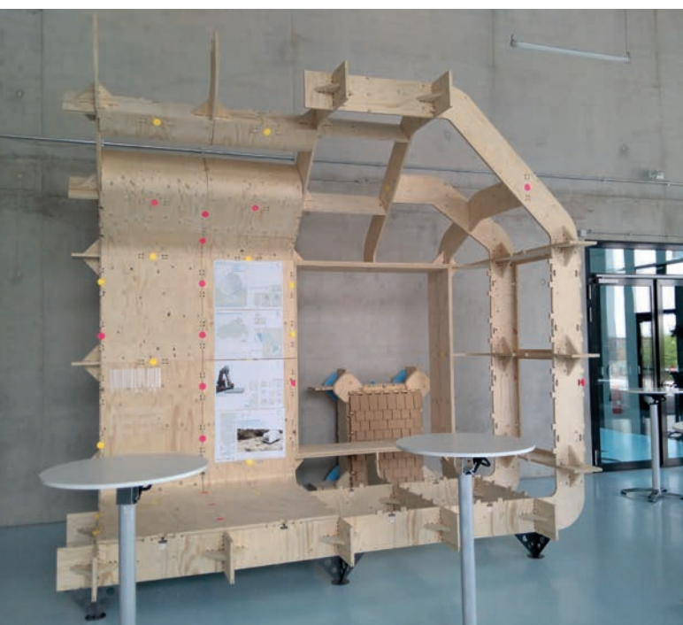
17 Detailmodell des digital gefertigten Ferienhausprototypen
